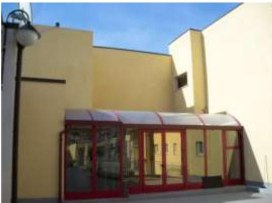
Il passaggio di intercomunicazione mette in collegamento il corridoio A e il corridoio B del primo piano. Ha copertura curvilinea in plexiglass e pareti perimetrali realizzate in alluminio e vetro di tipo antisfondamento. Anche le finestre basculanti realizzate su i due lati sono in alluminio e vetro. Il pavimento è in ceramica. Il passaggio è munito di porte vetrate e dotate di maniglioni antipánico che consentono l'evacuazione del piano sul terrazzo adiacente alla scala di emergenza 2.
